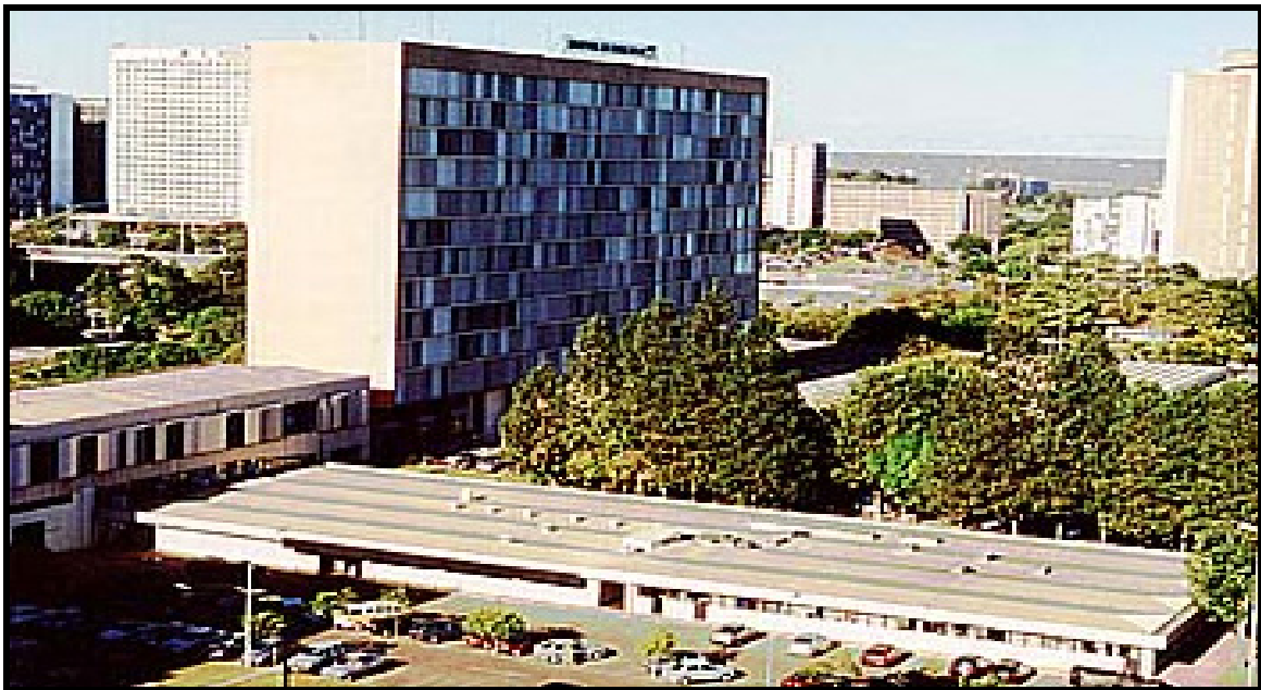
FIGURA 1- Hospital de Base do Distrito Federal (HBDF) localizado em Brasília – DF.
